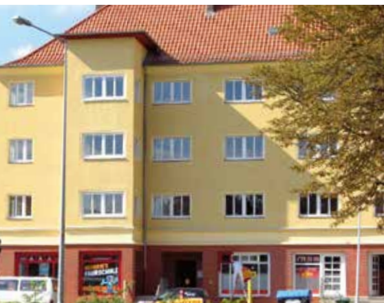
Seit 2008 saniert und renoviert, erstrahlt das „erste“ Haus am Platz
