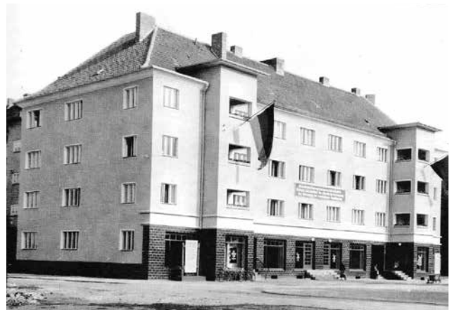
Das schönste Haus in Brandenburg nach der Fertigstellung im August 1955
